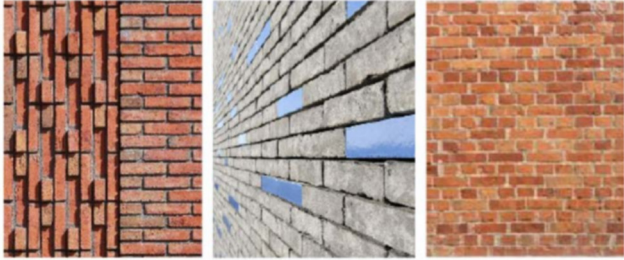
Referenties van variaties in relief in het metselwerk en een eigentijdse vertaling van het architecturaal detail van het station
