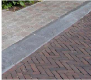
Natuursteenbanden tussen de voet- en fietspaden op het Stationsplein en het Transferium
