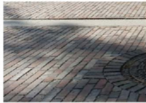
Shared Space voetgangers gebied: gebakken klinkers, waalformaat, halfsteenvoerband
