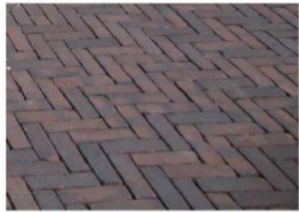
Shared Space rijweg: gebakken klinkers, dikformaat, keperverband
