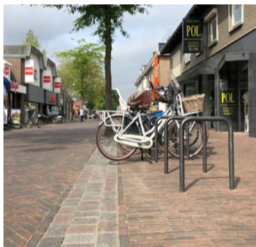
De gidslijn/afwateringsgoot die hier gehinderd wordt door een fiets.
