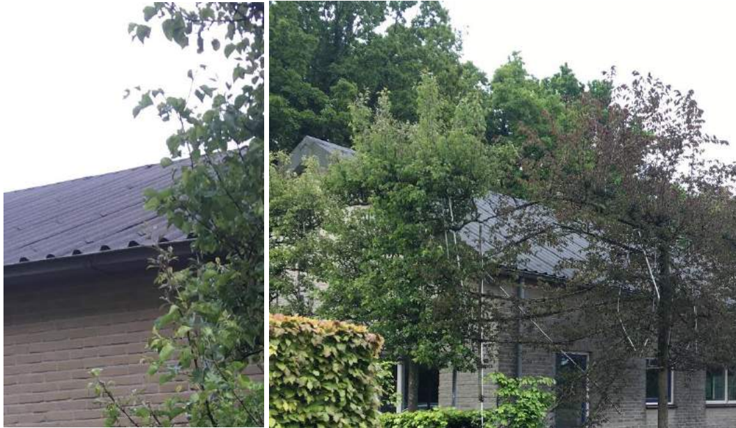
Figuur 8. Weergave van het stenengebouw met het enkele, golfplaten dak en de dakgoot. Opname 7 mei 2019
