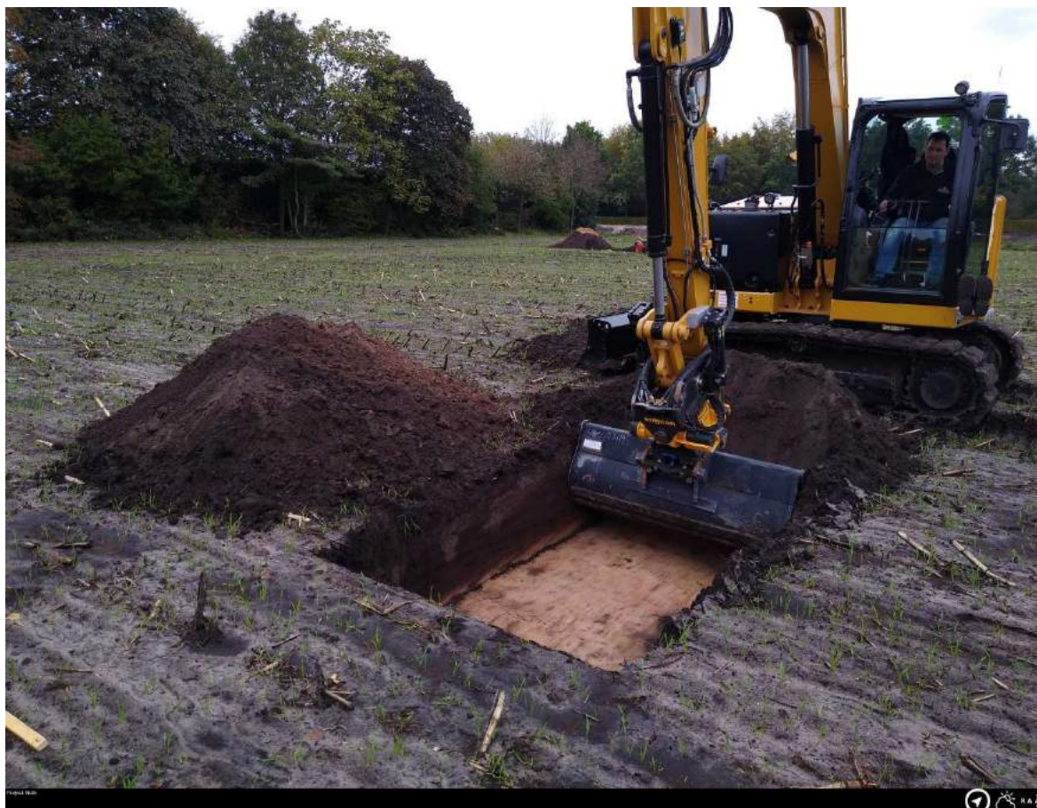
Figuur 5. Aanleg van profielputten met midi-kraan.
