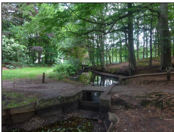
Afb. 4.19: De 'Cascade', een gemetselde stuw met houten planken en brugdek. Op de voorgrond zijn in de oevers natuurstenen elementen aanwezig.
