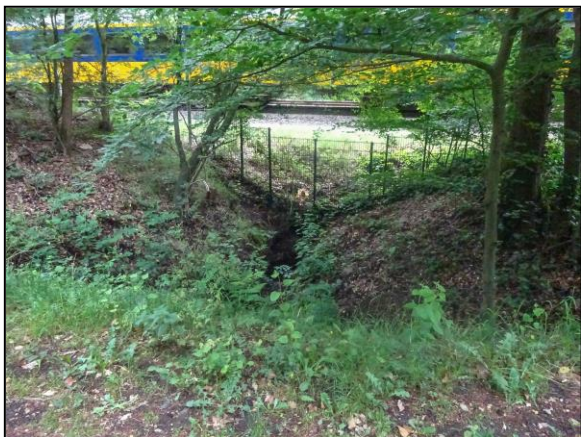
Afb. 4.10: Duiker onder de spoorlijn waardoor de Zilverbeek voert.
