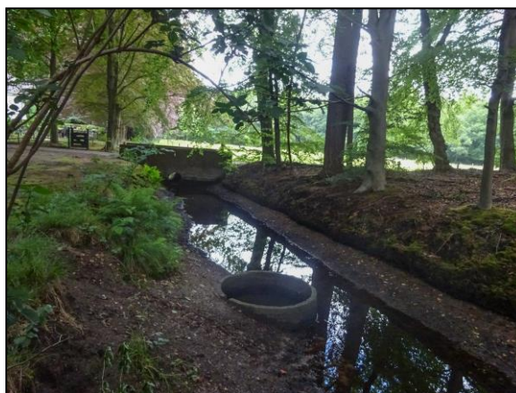
Afb. 4.20: Zicht vanaf de Cascade in noordelijke richting over het reservoir met ronde bak. Op de achtergrond de gemetselde brug met duiker (links achter de bomen de tuinmanswoning).
