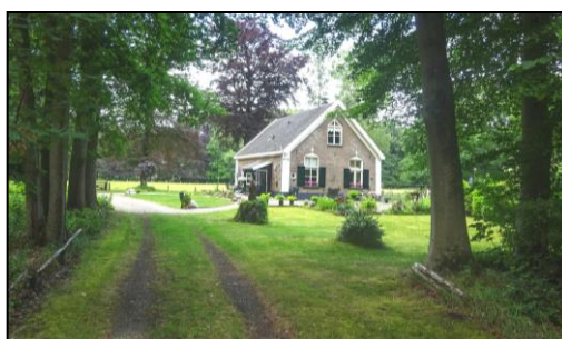
Afb. 1.16: De tuinmanswoning, gezien vanuit het oosten.
