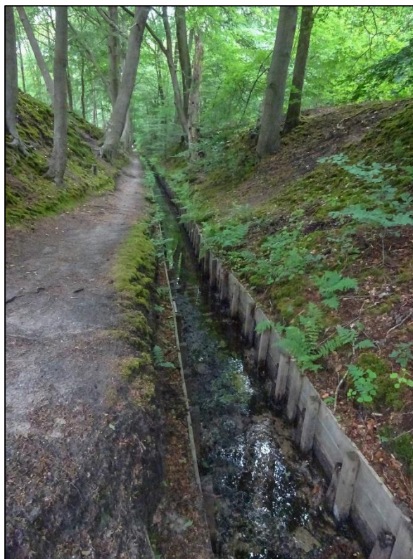
Afb. 2.30: Hersteld wandelpad langs het zuidelijke deel van de Zilverbeek.
