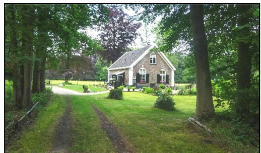
Afb. 1.16: De tuinmanswoning, gezien vanuit het oosten.
