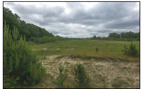
Afb. 1.32: Ecoduct Hulshorst, gezien in zuidelijke richting.
